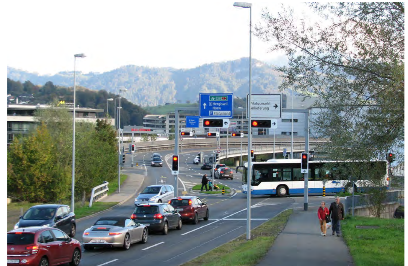
Heute dominieren Infrastrukturbauwerke und auf den MIV ausgerichtete Strassen den öffentlichen Raum in LuzernSüd. Schritt für Schritt soll dieses Gebiet nun in einen lebendigen, qualitätsvollen Lebensraum umstrukturiert werden (Quelle: Kontextplan, 2015).
