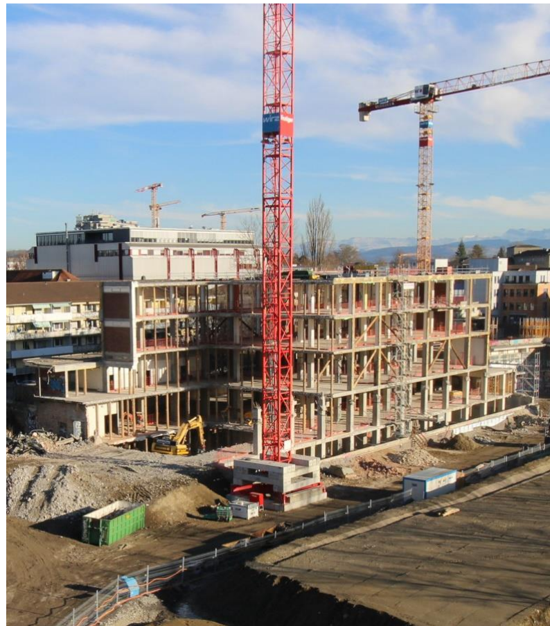
Chantier Holligerhof 8 © Coopérative Warmbächli
