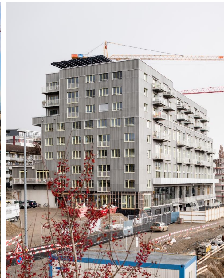
Holligerhof 8 © BHSF Architekten
